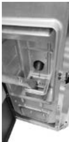
Fig. 34 - Czyszczenie miejsca na ruszt paleniskowy
