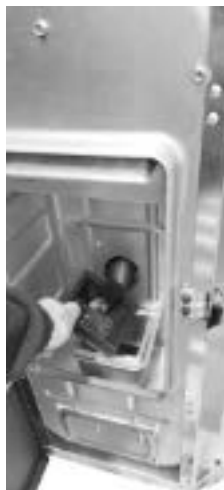
Rys. 32 - Odsysanie paleniska Rys
